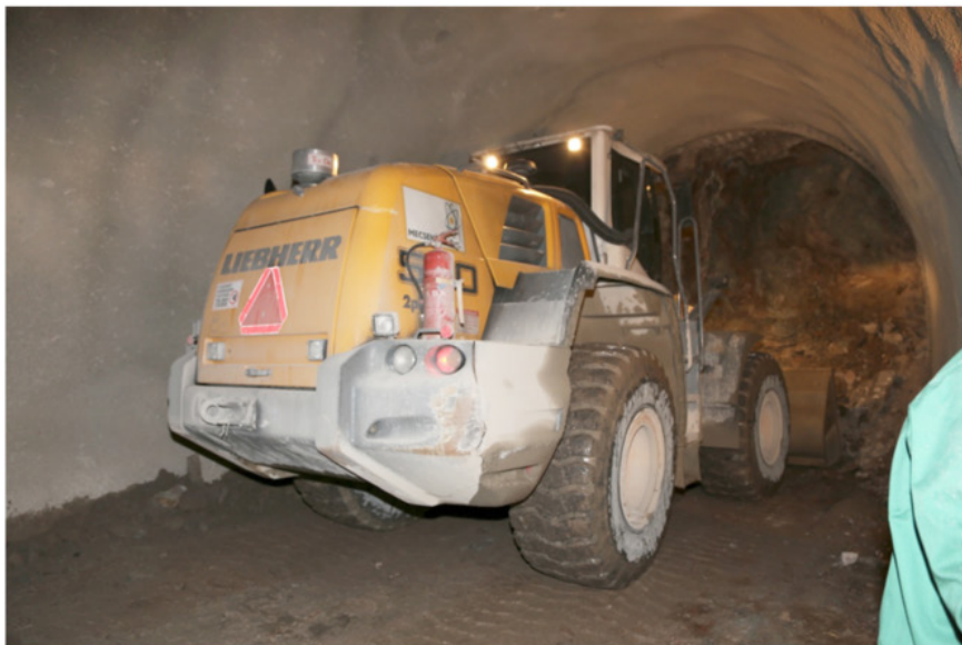
5. ábra. A térkiképzésben használt Liebherr gyártmányú bagger és rakodó berendezések
