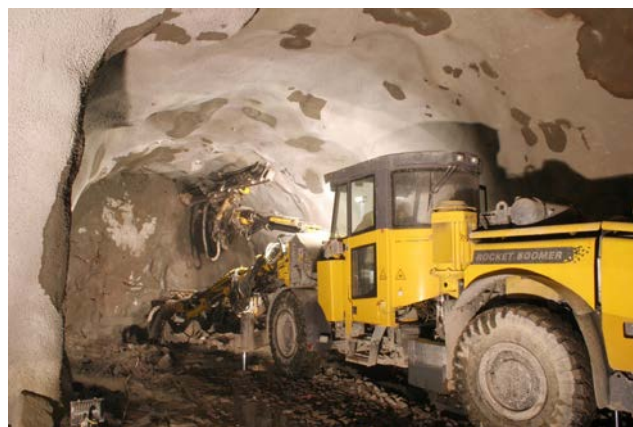
4. ábra. A térkiképzés során alkalmazott robbantólyukfúró berendezés (Atlas Copco Rocket Boomer L2/C)
