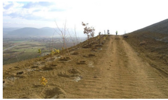
6. ábra. Egy sor cserje és két sor fa ültetése széles teraszra (kivitelezés közbeni fotó)
