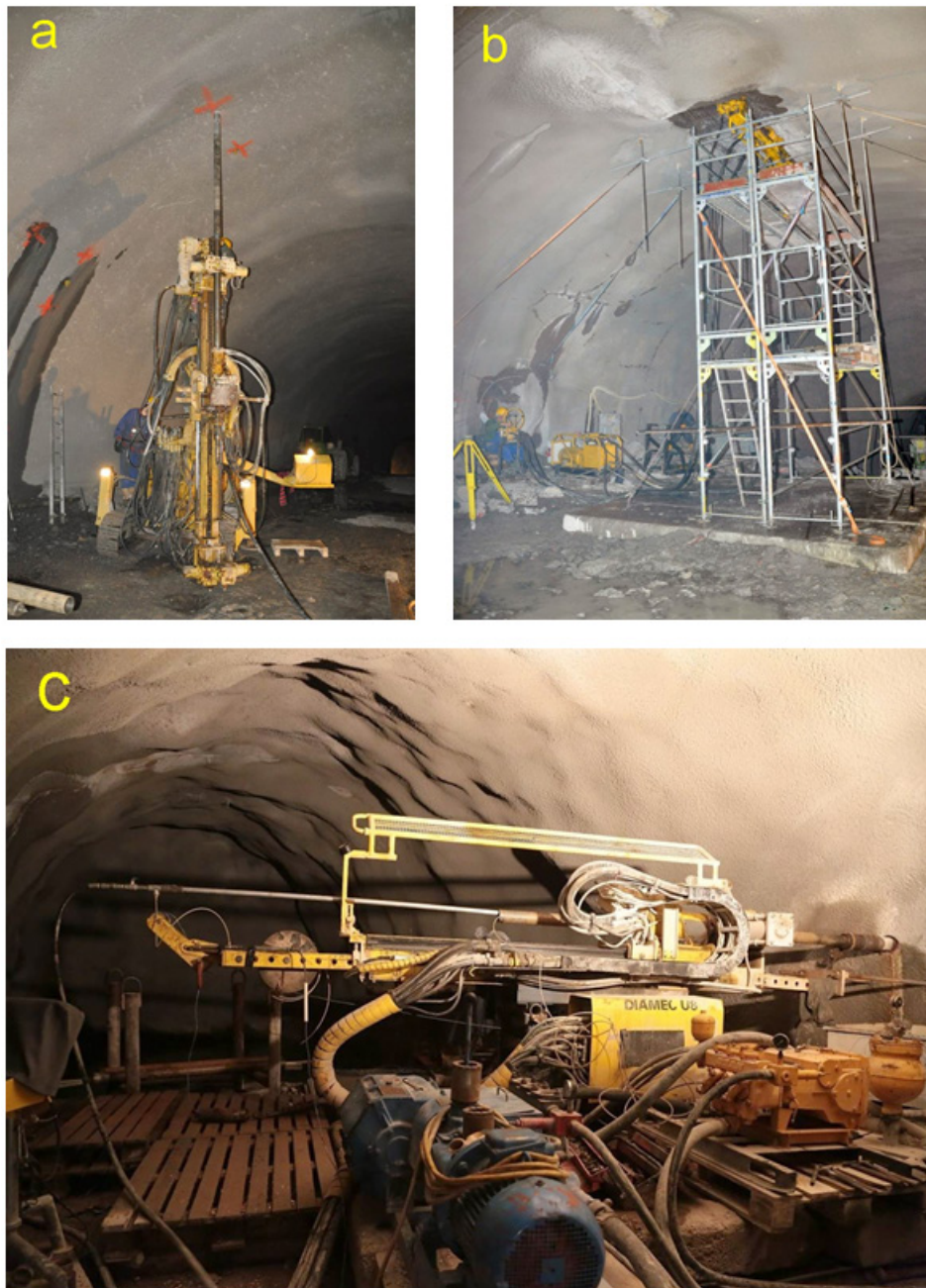
4. ábra. Kitekintő fúrás (BeR-17), CSIRO HI-cellás fúrás (b-Bkc-20) és vágatelőfúrás (c-BN2-1) kivitelezése
