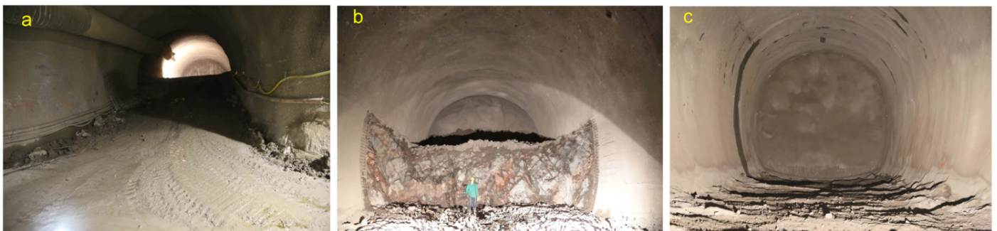
3. ábra. A tárolókamra kialakításának szakaszai (a-kalott, b-talpszelet, c-teljes kamra)
